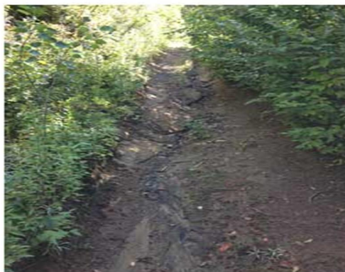
Figure 1. Les chemins forestiers en pentes fortes se transforment souvent en lit de cours d'eau et ce, sur plusieurs kilomètres. Ceci entraîne un apport important de sédiments dans les cours d'eau.
