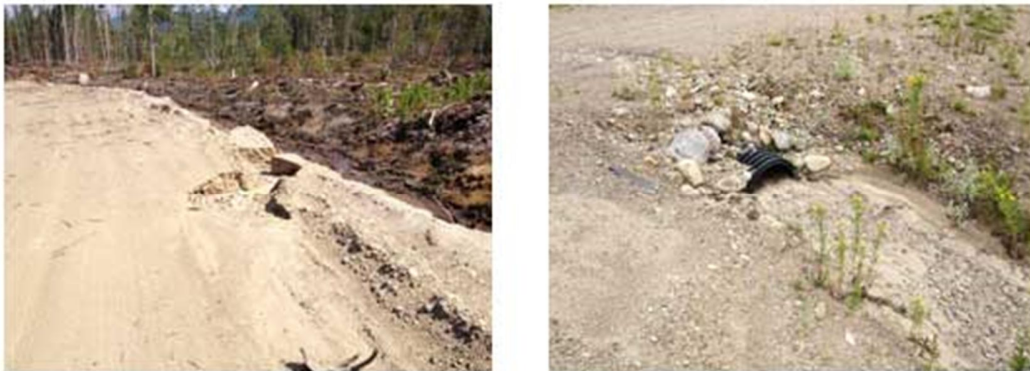
Figure 3. Certains chemins forestiers provoquent la mise en suspension de particules fines qui peuvent avoir des conséquences importantes sur les cours d'eau, obstruer des ponceaux et empêcher la libre circulation des eaux.
