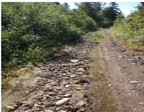
Figure 1. Les chemins forestiers en pentes fortes se transforment souvent en lit de cours d'eau et ce, sur plusieurs kilomètres. Ceci entraîne un apport important de sédiments dans les cours d'eau.
